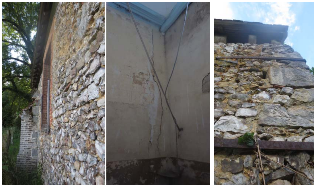
Fissures intérieures de part et d'autre du mur sud-est, pilastre désolidarisé, pignon nord-est qui s'écarte, about d'entrait qui pourrit
