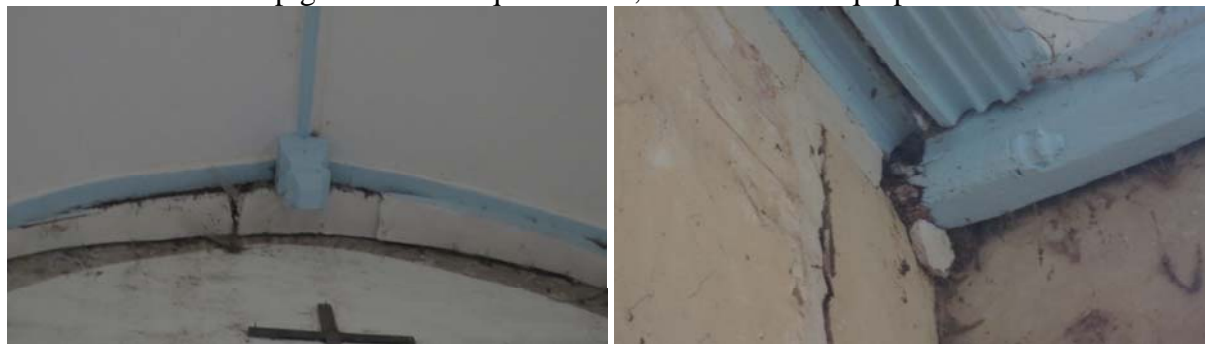
Fissures intérieures de part et d'autre du mur sud-est, pilastre désolidarisé, pignon nord-est qui s'écarte, about d'entrait qui pourrit
